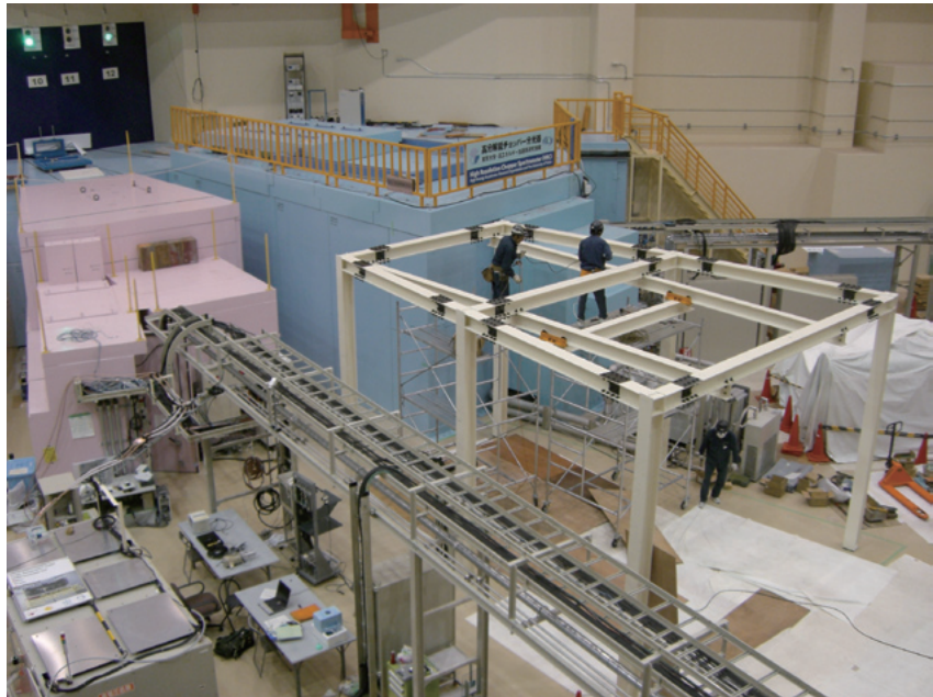
図3 建設が始まった高圧中性子ビームライン PLANET (BL11: クリーム色の骨組み)。既に建設が完了している中性子源特性試験装置 (BL10: ピンク色のユニット) と高分解能チョッパー装置 (BL12: 水色のユニット) にはさまれた空間にビームラインが建設される。
