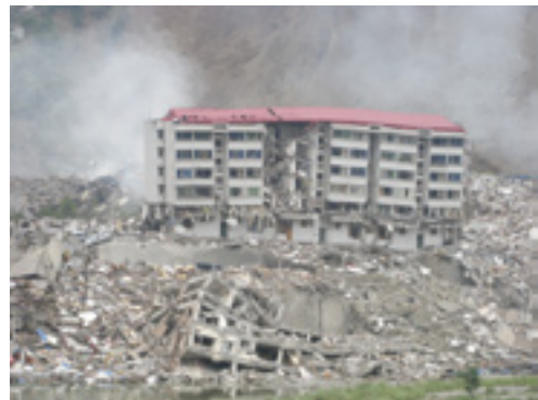
写真2 四川省北川の建物の倒壊現場。
