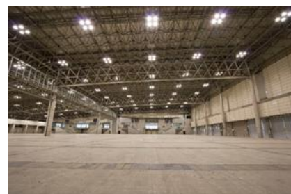
展示ホール8 (奥が国際会議場側)
