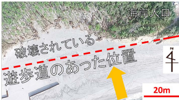
図3. 台風通過後の海岸入口西側の空撮
