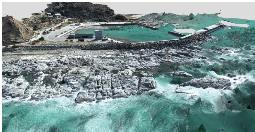
図1 UAS-SfMにより計測された能登半島鹿磯漁港の隆起ベンチの3Dモデル。小倉拓郎氏提供。https://skfb.ly/oSPqn
