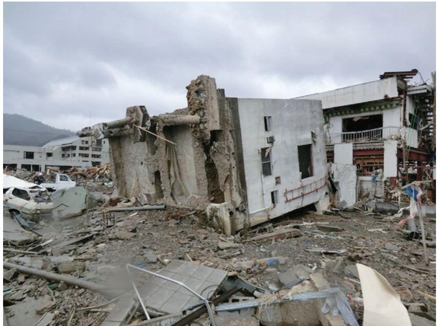
図3 宮城県女川町で被災した建物。基礎パイプなどに、地震動による津波到達前の破損がみられる。
